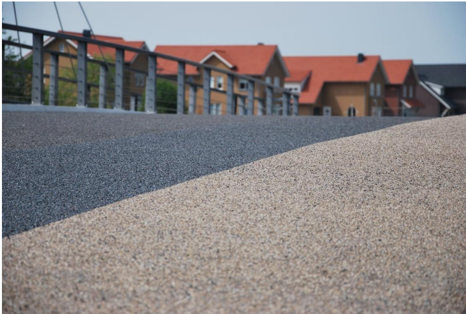
Figuur 17: Epoxy slijtlaag op het brugdek
